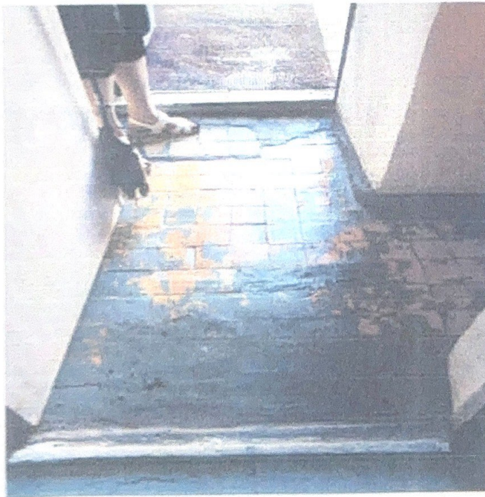
ФОТО № 6 Дополнительные входа в группы: Высота порогов и перепад высот более 14мм, ширина дверных проёмов менее 90см, размер тамбура = 1,3* 0,9 метра, что не соответствует нормам.
